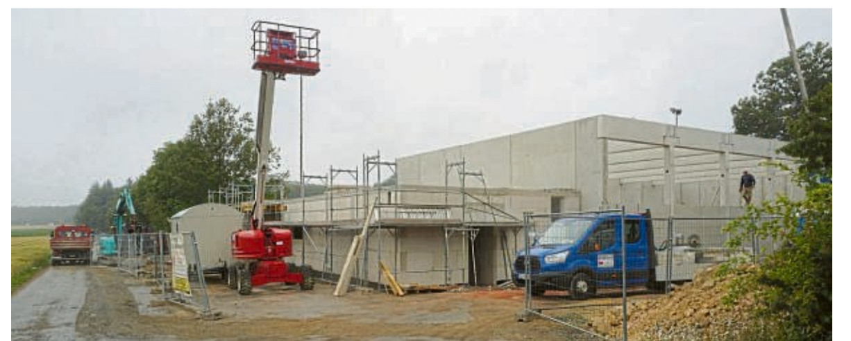
Die Bauarbeiten an der Sporthalle am Oberloh sind weit fortgeschritten; an den Außenwänden ist die Größe gut zu erkennen. FOTOS: MAI
